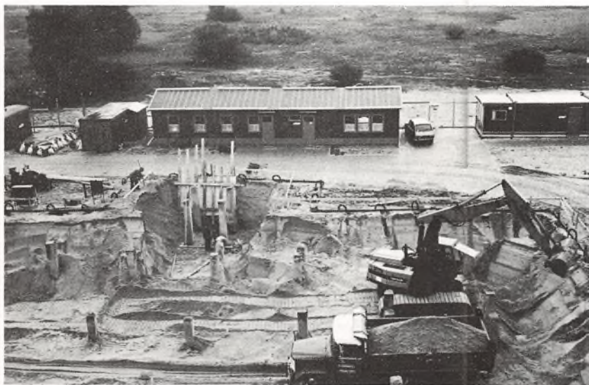
Het fundament voor de districtcentrale in Lelystad.
