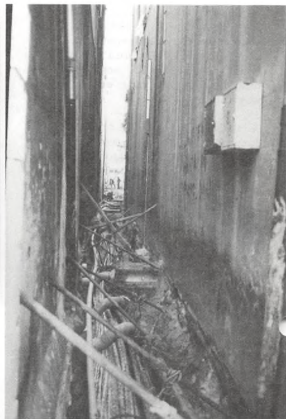
Kabels onder de rioleerafvoerstukken verder op hunweg door de Hamsteeg
