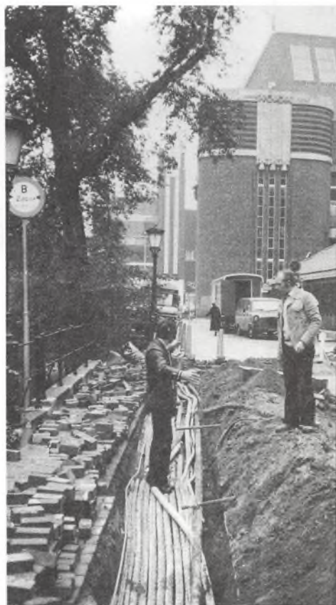
Kabellegging zijde Oudegracht, op de achtergrond de DC 1
