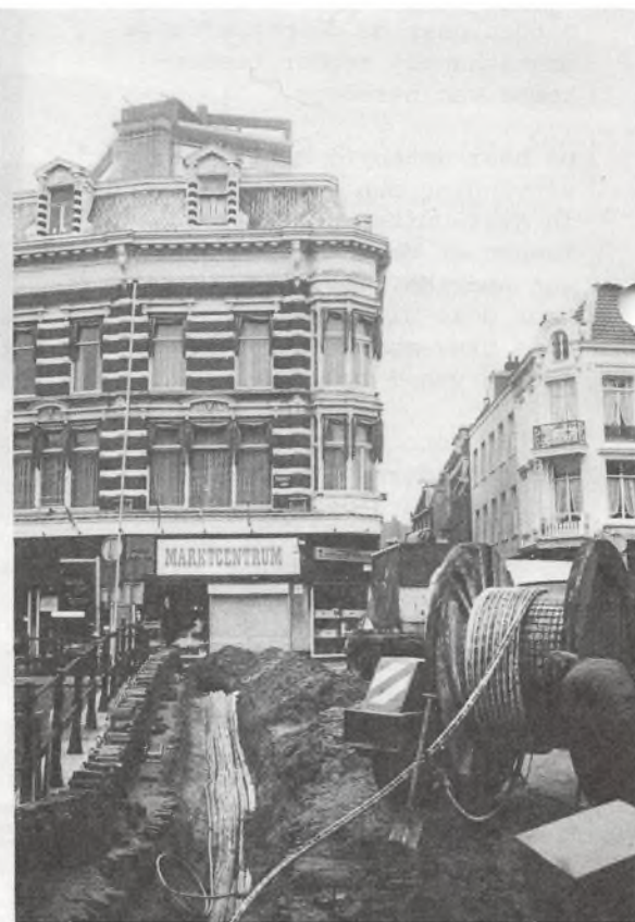
Kabellegging zijde Oudegracht, op de achtergrond de DC 1
