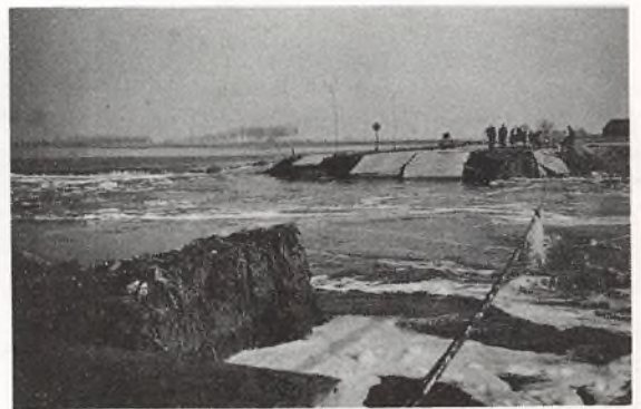
Weggeslagen rijksweg tussen Rilland en Kruiningen.
