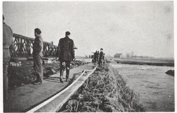
Februari 1953: Opbouw van de Baileybrug voor telefoon- en electriciteitskabels en waterleidingbuizen.
